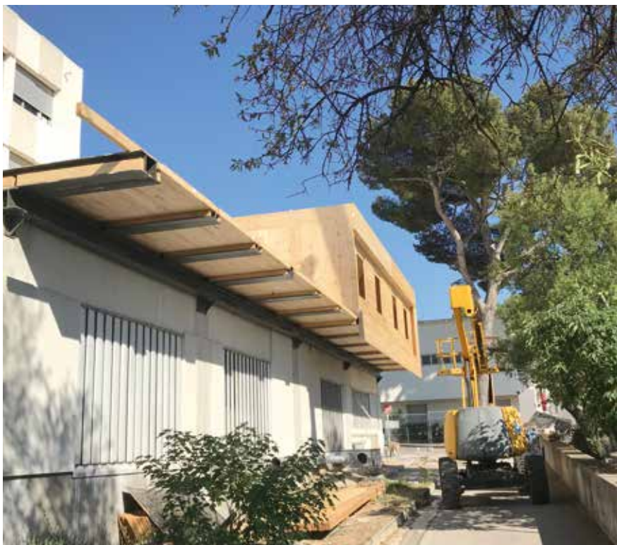
Une extension de la Clinique Chantecler en cours de construction.
